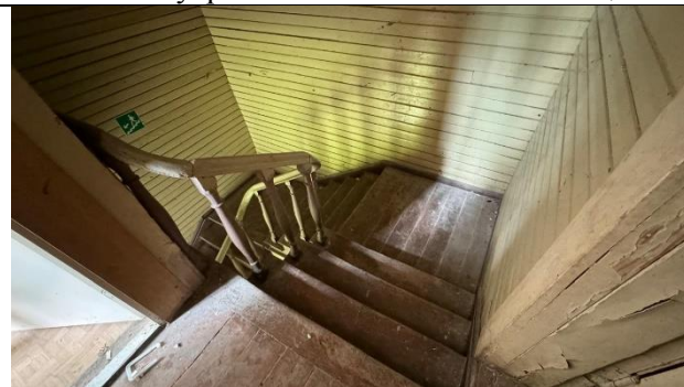
Фото 41. Внутреннее состояние Объекта оценки
