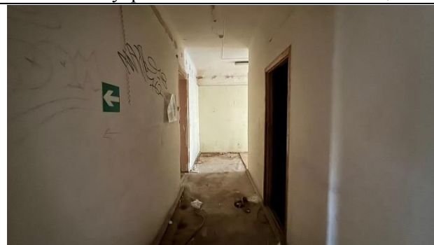
Фото 17. Внутреннее состояние Объекта оценки
