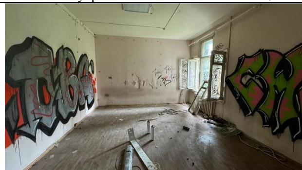
Фото 23. Внутреннее состояние Объекта оценки
