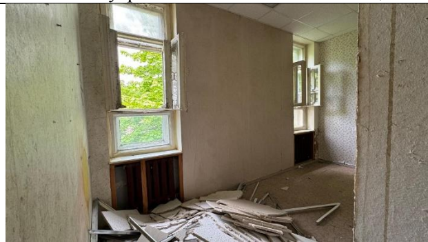
Фото 42. Внутреннее состояние Объекта оценки
