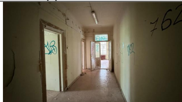
Фото 19. Внутреннее состояние Объекта оценки
