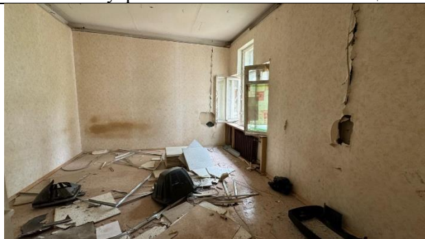
Фото 34. Внутреннее состояние Объекта оценки
