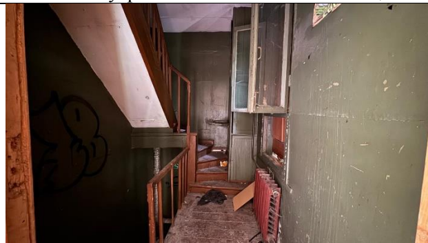
Фото 38. Внутреннее состояние Объекта оценки
