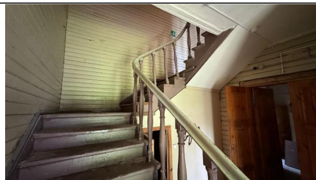
Фото 25. Внутреннее состояние Объекта оценки
