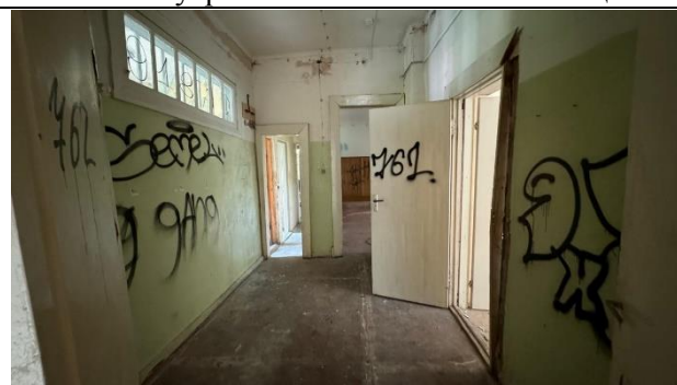
Фото 29. Внутреннее состояние Объекта оценки
