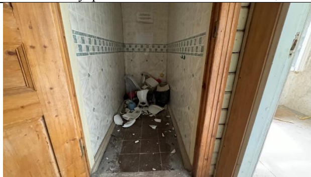
Фото 28. Внутреннее состояние Объекта оценки
