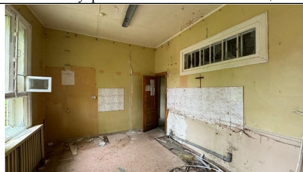
Фото 39. Внутреннее состояние Объекта оценки
