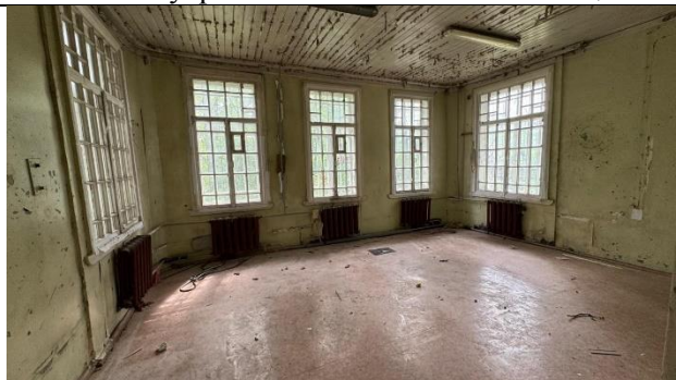
Фото 22. Внутреннее состояние Объекта оценки
