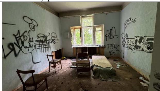
Фото 40. Внутреннее состояние Объекта оценки
