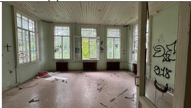
Фото 32. Внутреннее состояние Объекта оценки
