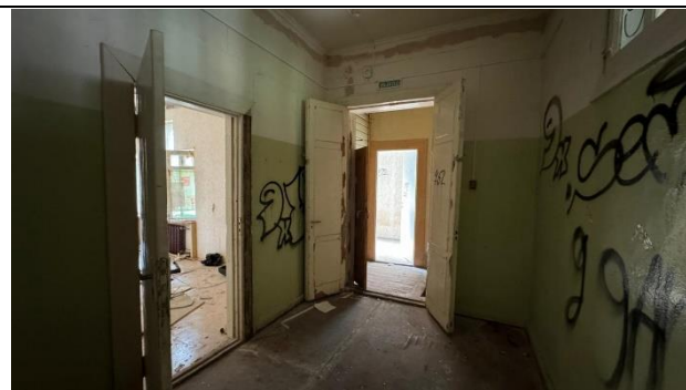
Фото 35. Внутреннее состояние Объекта оценки
