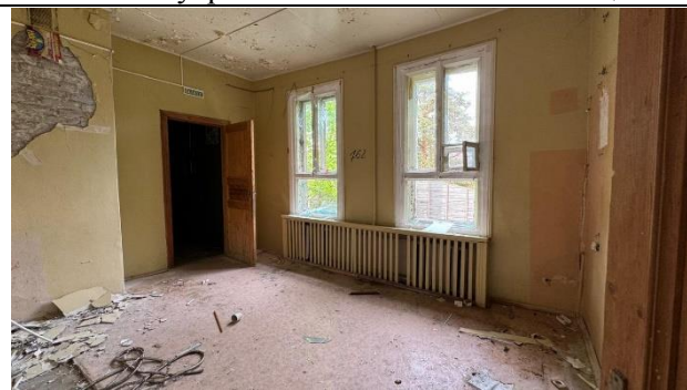
Фото 37. Внутреннее состояние Объекта оценки
