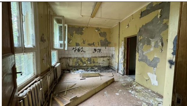
Фото 16. Внутреннее состояние Объекта оценки
