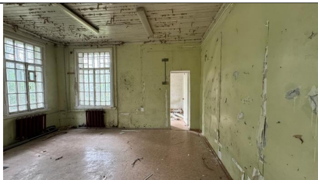
Фото 26. Внутреннее состояние Объекта оценки
