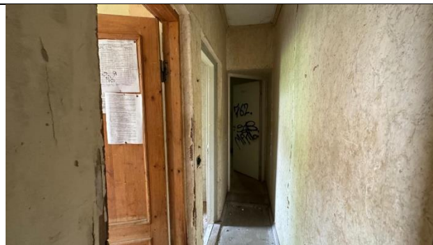
Фото 36. Внутреннее состояние Объекта оценки
