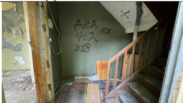
Фото 18. Внутреннее состояние Объекта оценки
